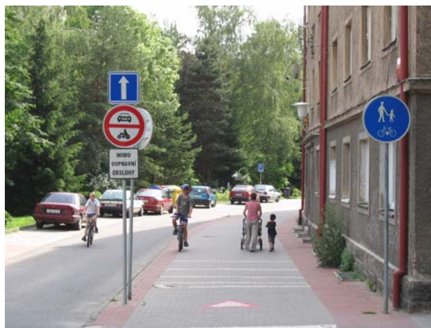
Obr. 3.19b: Příklad řešení vedení stezky pro chodce a cyklisty se společným provozem jednosměrnou komunikací (Liberec)
