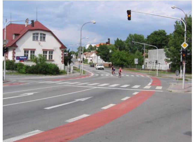
Obr. 3.9b: Příklad řešení vedení vyhrazených jízdních pruhů v HDP prostorem křižovatky (Břeclav)
