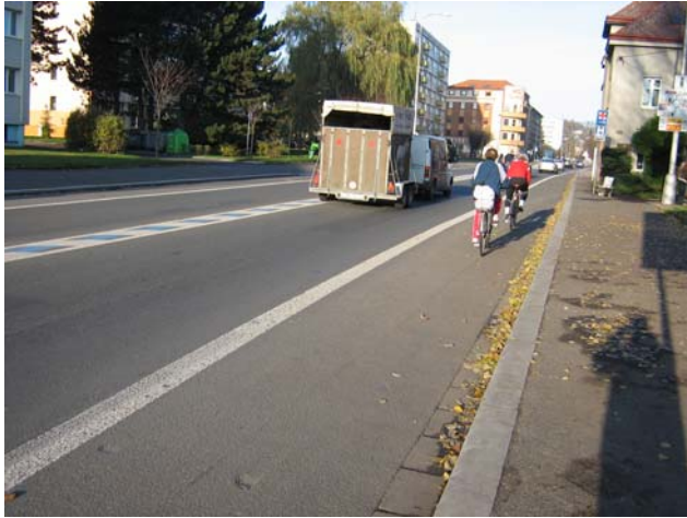
Obr. 3.11a: Ulice Pražská v blízkosti křižovatky ulic Pražská x Na Hamrech (pohled směrem do centra) – současný stav
