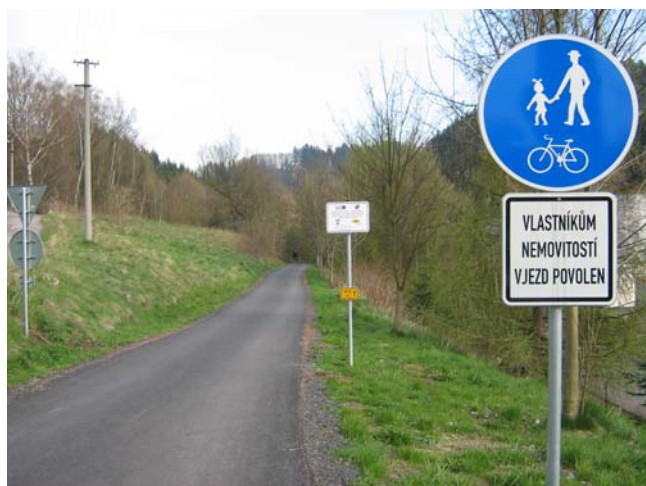
Obr. 2.6: Začátek stezky pro chodce a cyklisty na okraji Náchoda u ČOV v Bražci
