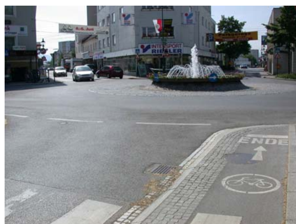
Obr. 3.22b: Příklad ukončení vyhrazených jízdních pruhů pro cyklisty před okružní křižovatkou (Tulln, Rakousko)
