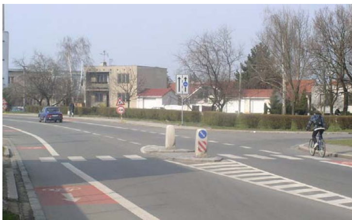
Obr. 3.7b: Příklad užití jednosměrných oboustranných jízdních pruhů pro cyklisty v HDP v místě přechodu pro chodce (Břeclav)
