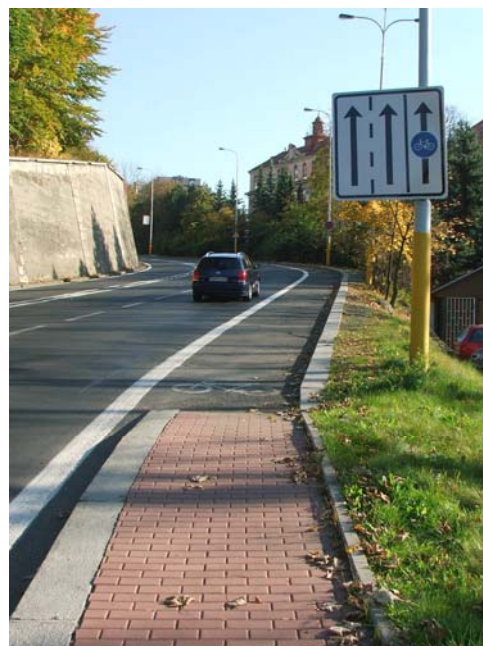
Obr. 3.17b: Příklad užití jednosměrných oboustranných jízdních pruhů pro cyklisty v HDP (Karlovy Vary)
