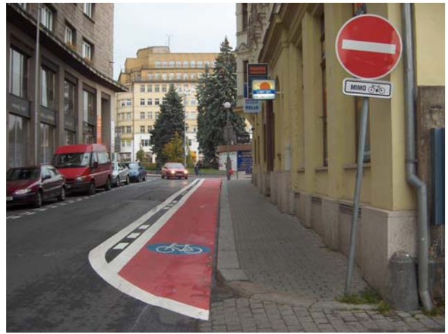
Obr. 3.18b: Příklad řešení vedení jednosměrného vyhrazeného jízdního pruhu pro cyklisty v jednosměrné komunikaci (Liberec)
