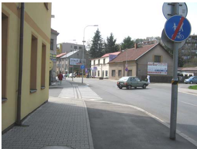
Obr. 2.18: Způsob řešení křížení stezky pro chodce a cyklisty s ulicí na Václaváku
