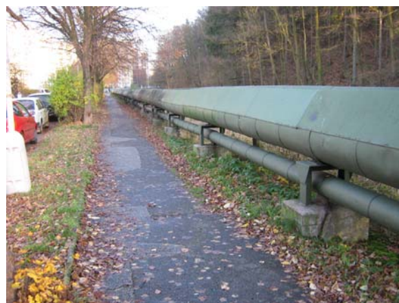
Obr. 3.2b: Současný stav vedení parovodního potrubí v ulici Mánesovo nábřeží
