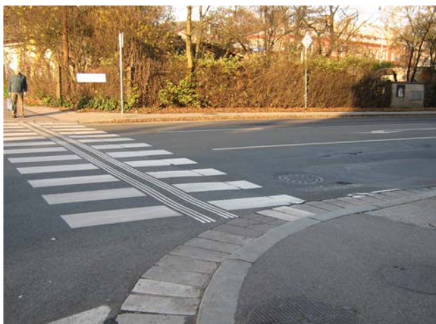
Obr. 3.13a: Ulice Běloveská v místě přechodu pro chodce u křižovatky ulic Běloveská x Pražská – současný stav
