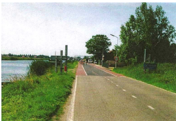
Obr. 3.4b: Řešení vyhrazených jízdních pruhů pro cyklisty v extravilánu
