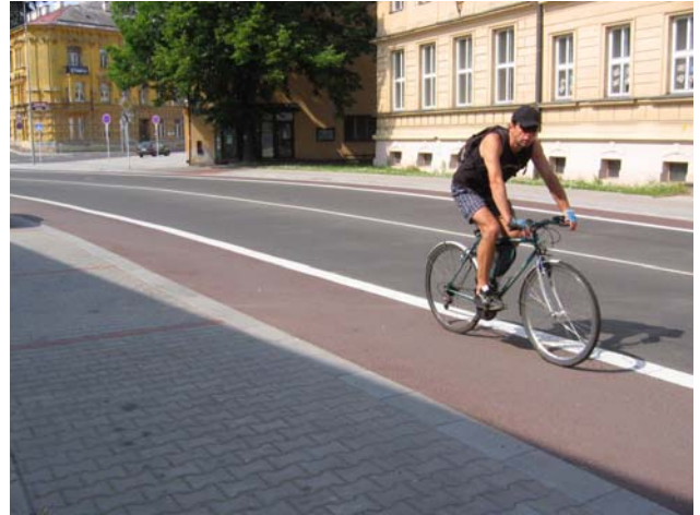
Obr. 3.14b: Příklad vedení jednosměrného jízdního pruhu pro cyklisty v HDP podél parkovacího pruhu (Šumperk)
