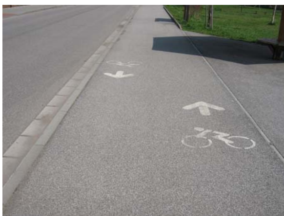
Obr. 2.16: Příklad použití asfaltového krytu v ulici 1. Máje s piktogramy jízdního kola
