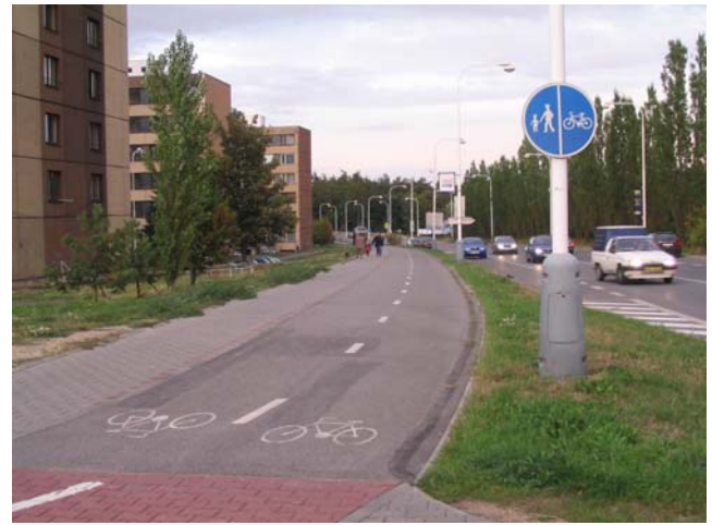
Obr. 3.20b: Příklad řešení vedení komunikace pro pěší a cyklisty s odděleným provozem – obousměrný provoz cyklistů (Kladno)
