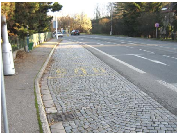
Obr. 3.8a: Ulice Českosalická v místě autobusové zastávky „Náchod, Rybárna“ (pohled směrem do centra) – současný stav
