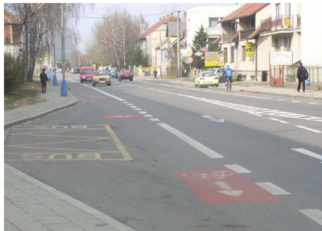
Obr. 3.8b: Příklad řešení vedení vyhrazeného jízdniho pruhu v HDP v místě autobusové zastávky (Břeclav)
