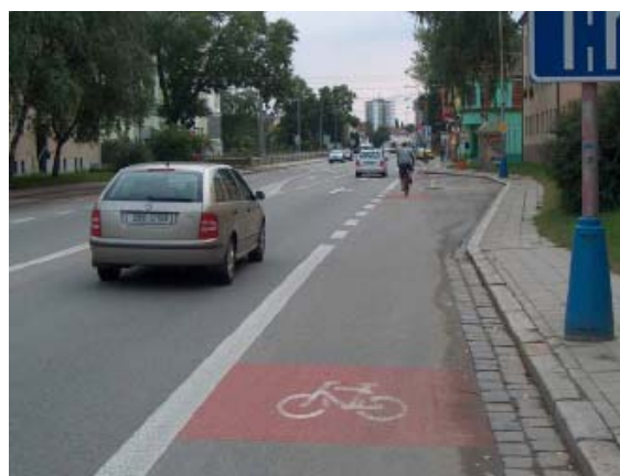
Obr. 3.26: Příklad vedení vyhrazeného jízdního pruhu pro cyklisty v místě zastávky (Brno)
