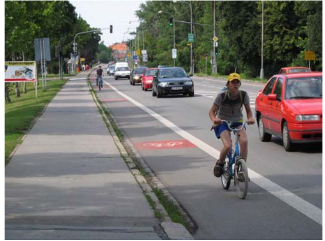
Obr. 3.11b: Příklad užití jednosměrných oboustranných jízdních pruhů pro cyklisty v HDP (Břeclav)
