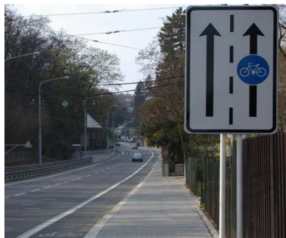
Obr. 3.16b: Příklad užití jednosměrných oboustranných jízdních pruhů pro cyklisty v HDP (Brno)
