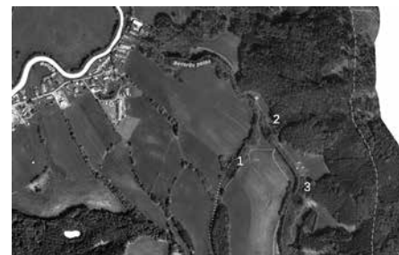
Letecký snímek studované oblasti povodí Bavorova potoka. Čísla označují polohu zmeliorovaného přítoku (1), zaniklého rybníčku (2) a koryta svedeného do betonových žlabů (3).
