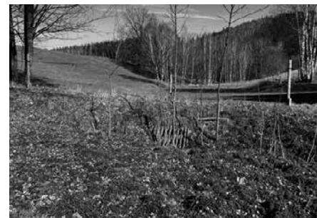
Přístupová skruž k zatrubněnému potoku
